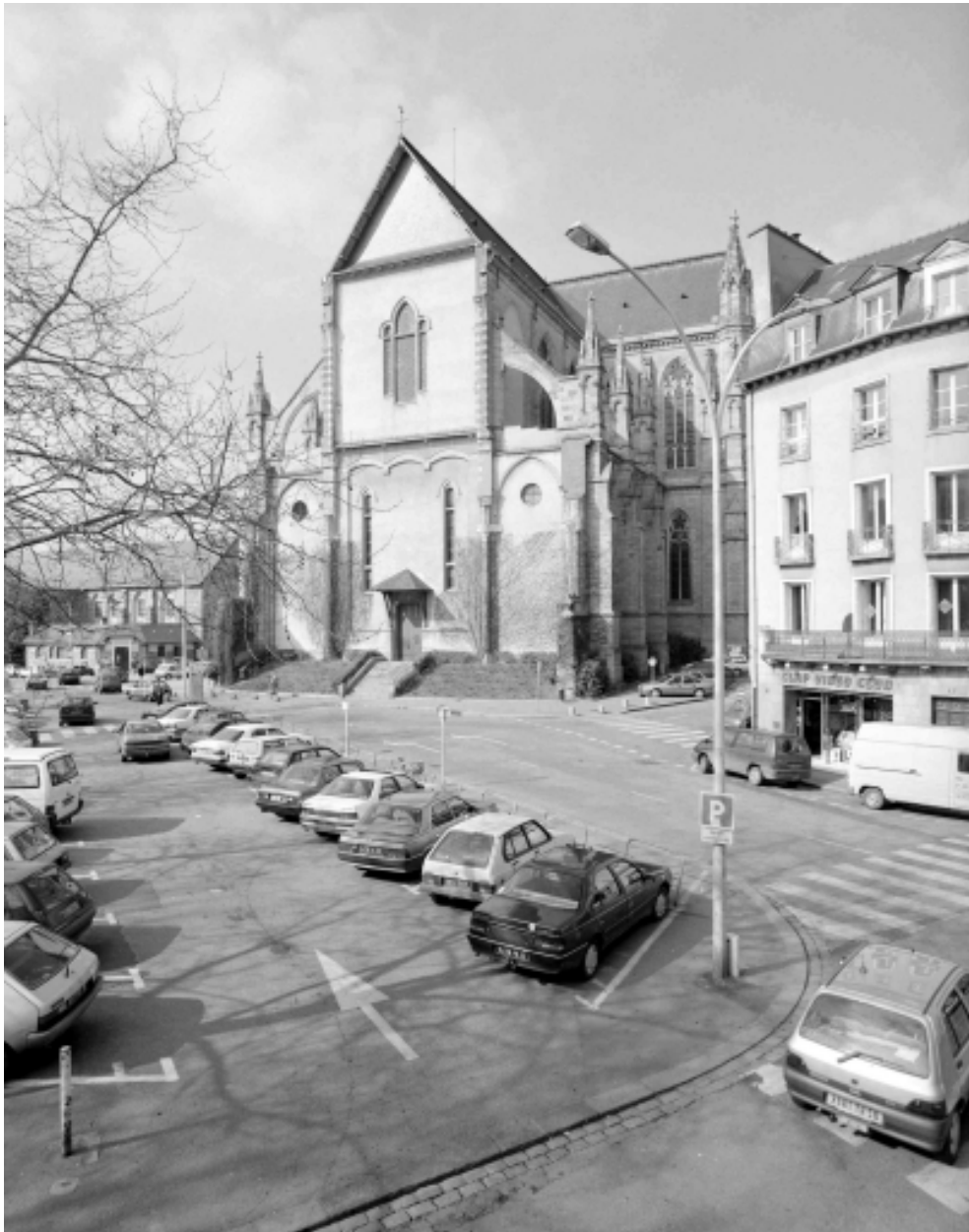
Elévation sud : vue générale
