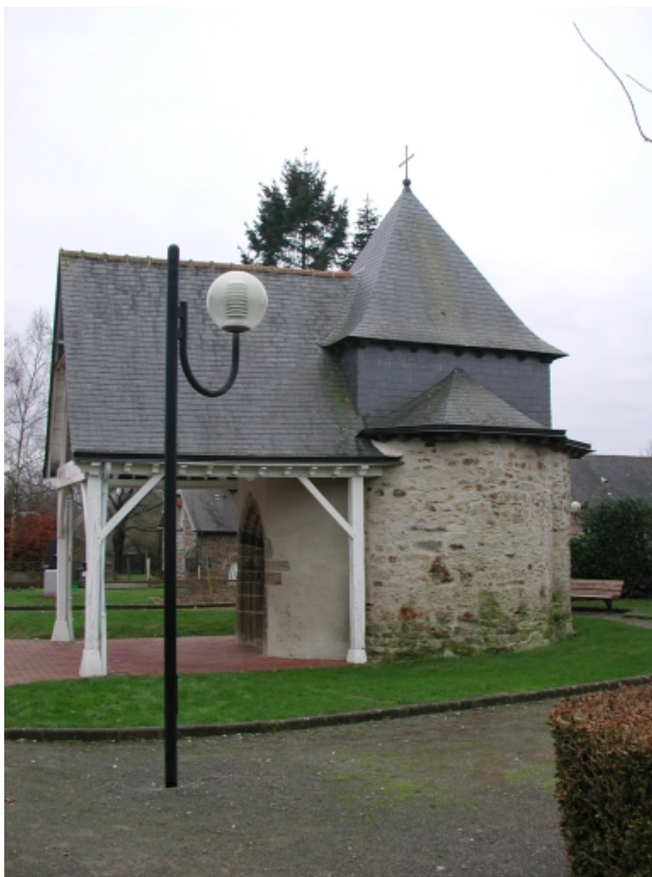
Vue générale nord
