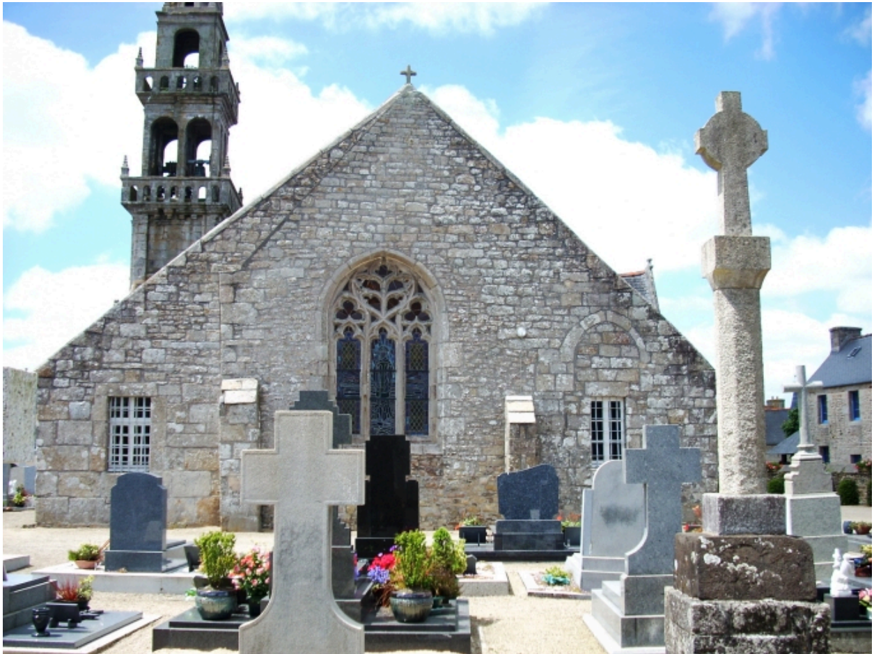
Saint-Vougay, église paroissiale Saint-Vougay : élévation est
