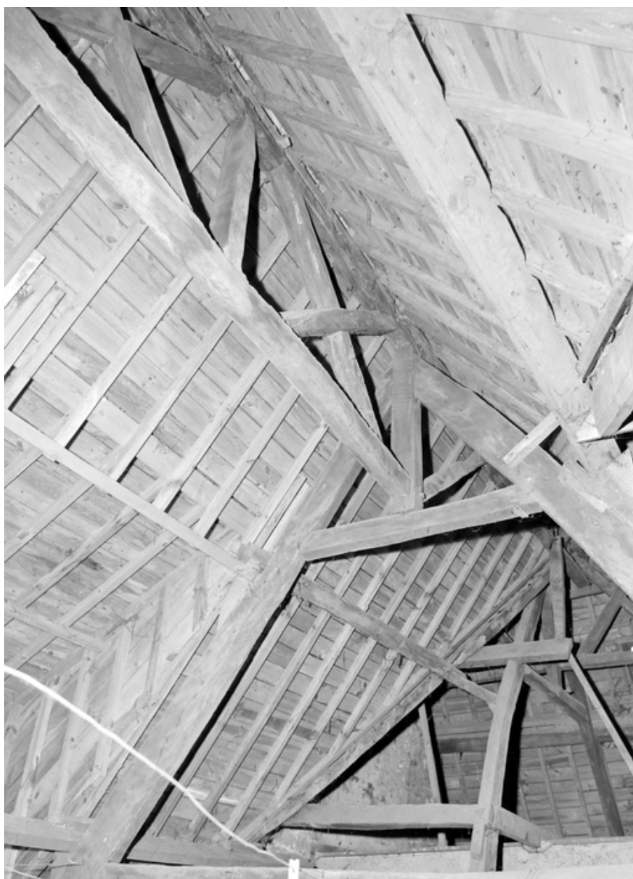
Charpente, vue générale d'une ferme (état en 1978).
