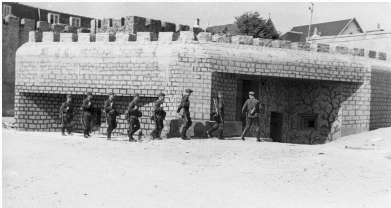
Vue d'une patrouille allemande devant le bunker - casemate (collection particulière). On notera le camouflage particulièrement bien soigné du bunker : merlons et créneaux de la dalle de couverture, faux appareillage et plantes grimpantes en peinture...
