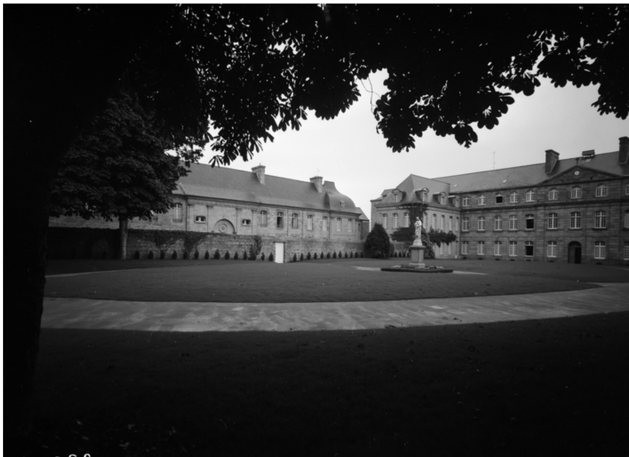
Vue générale, en diagonal (1974)
