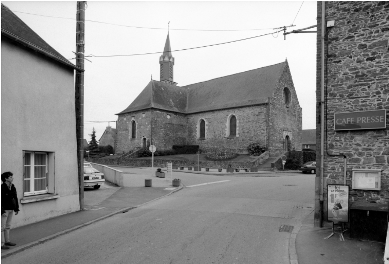
Elévation Nord-Ouest : vue générale
