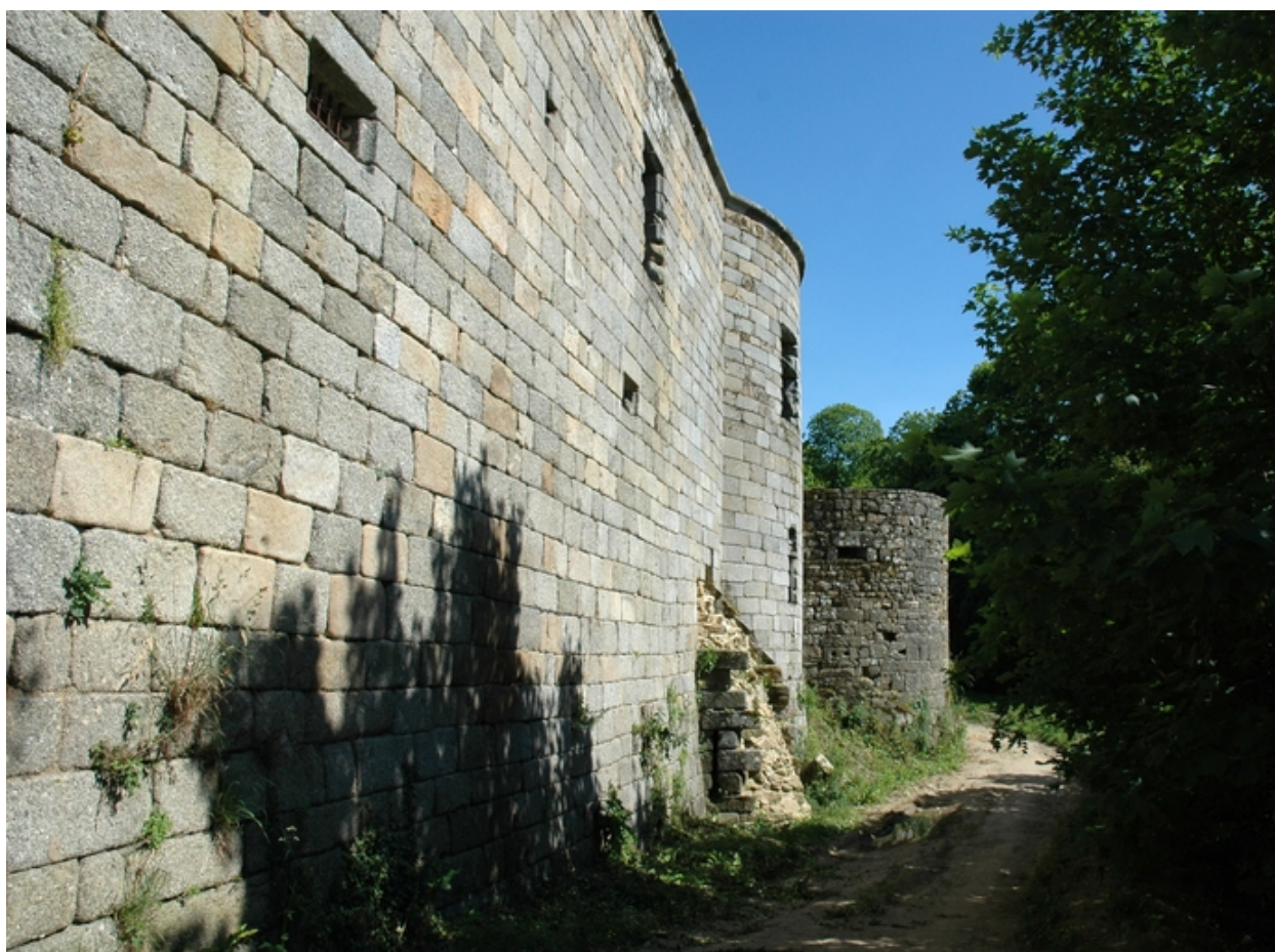
Vue du front ouest : emplacement d'un moineau ou caponnière
