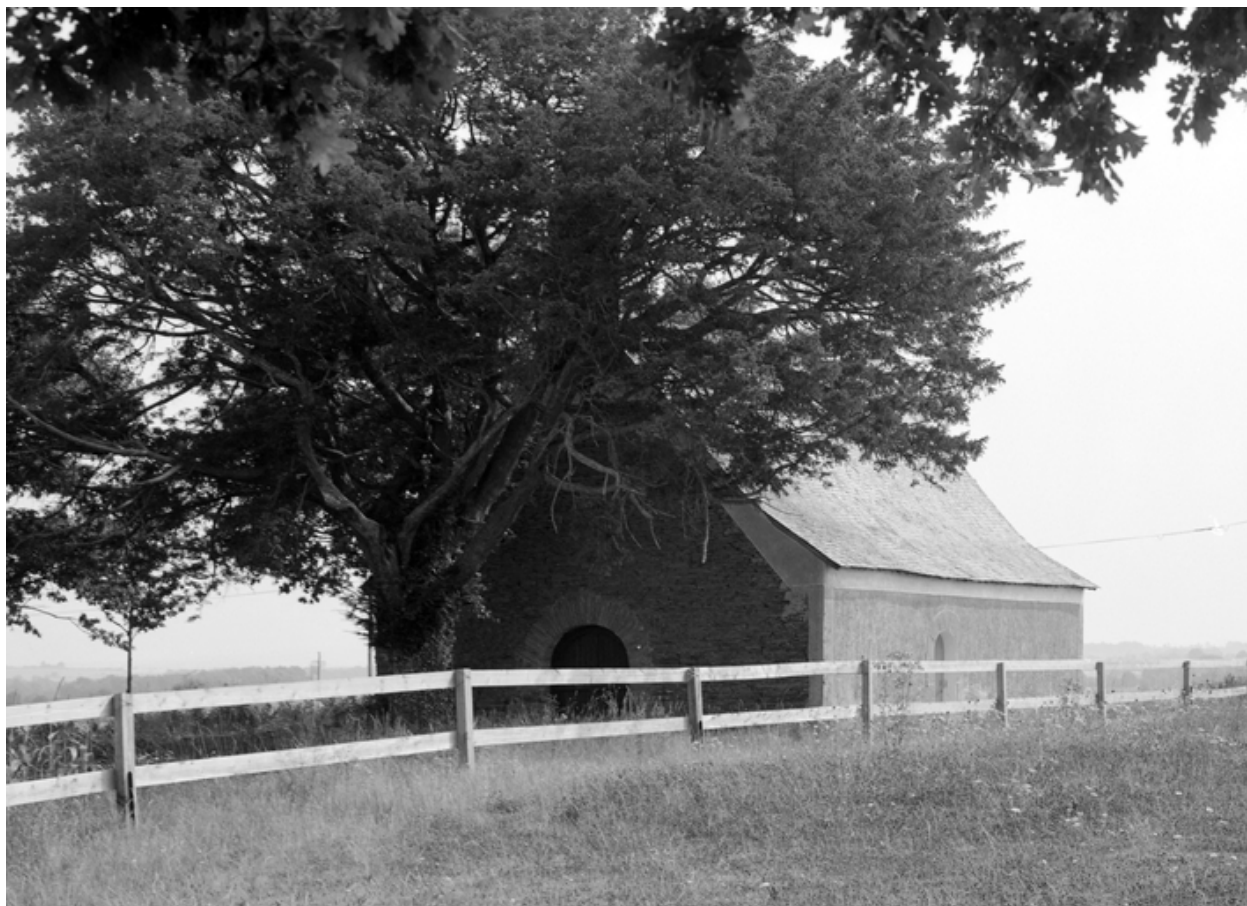
Chapelle vue du sud-ouest (état en 1984)
