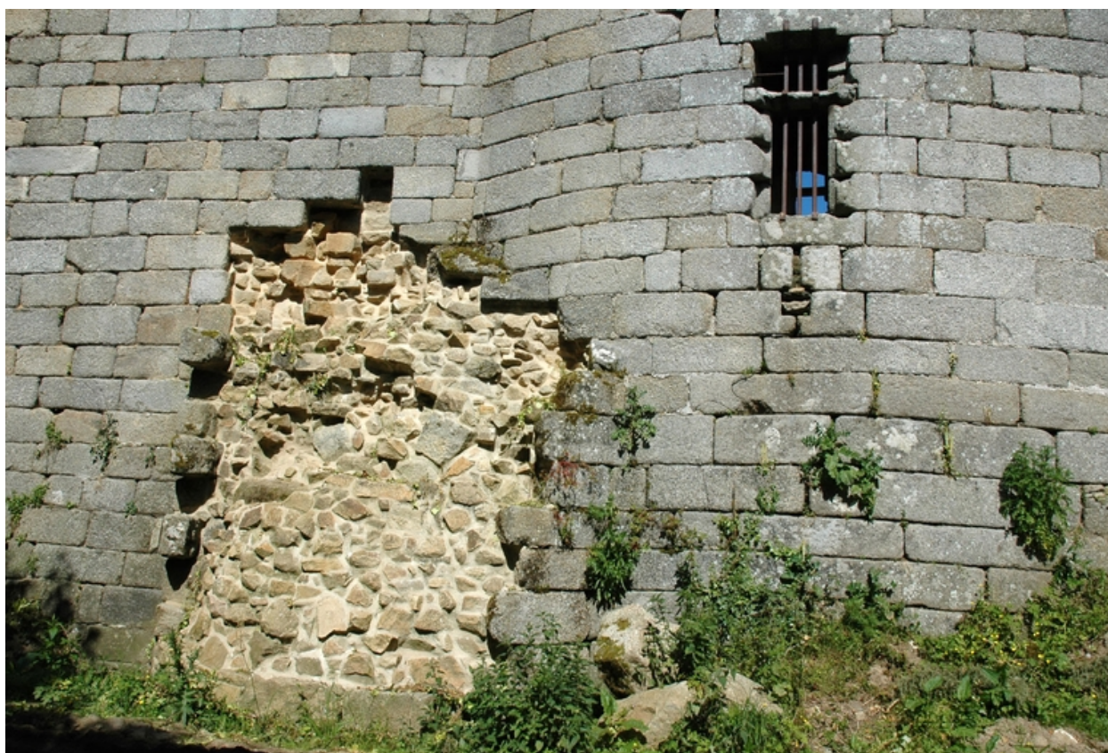
Vue du front ouest : emplacement d'un moineau ou caponnière
