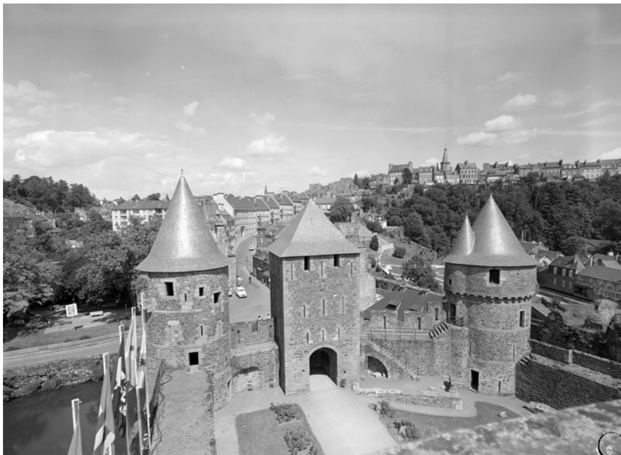
Entrée du château, vue générale ouest.
