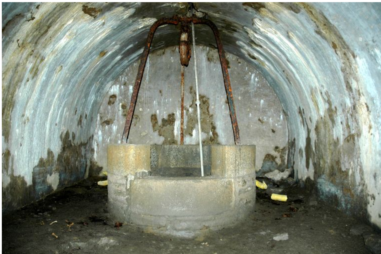
Vue du fort de Penfeld : le puits situé sous le passage d'entrée
