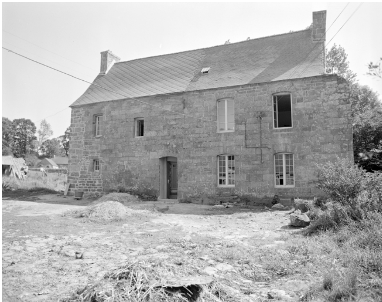
Vue générale nord
