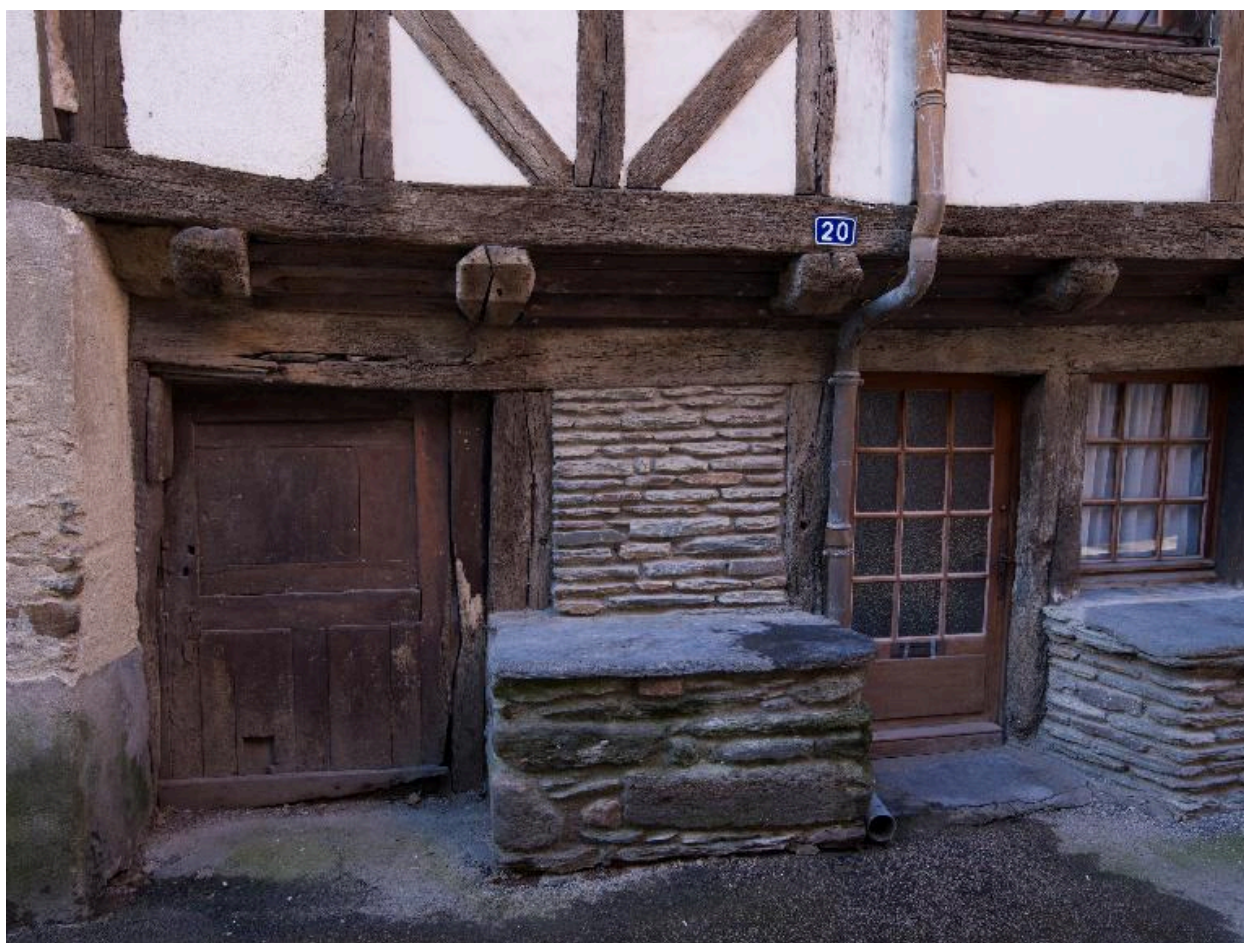
Maison : le rez-de-chaussée (état en 2012)
