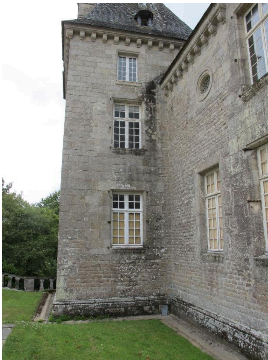
Pavillon nord est, façade sur cour
