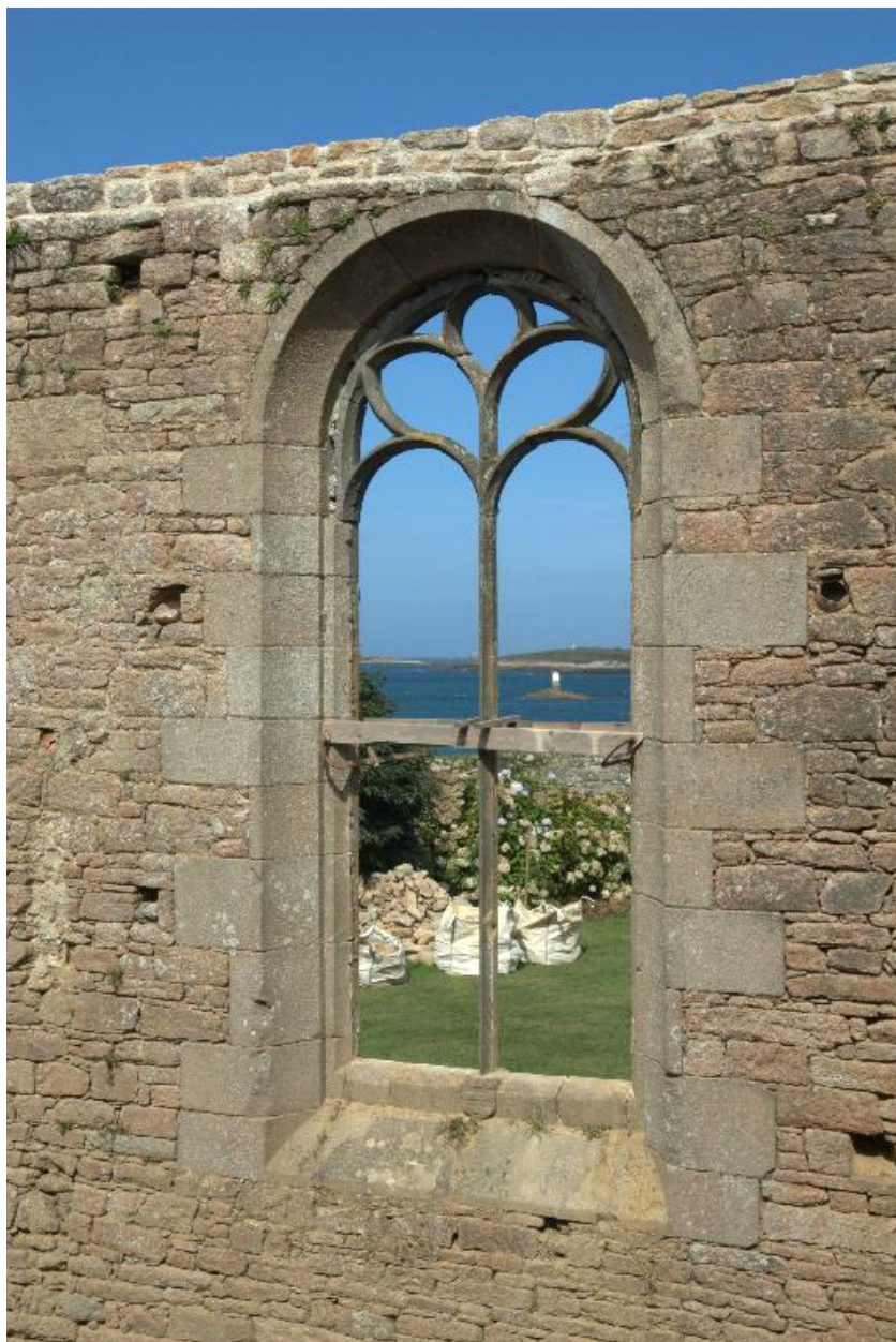
Vue du fenestrage du mur nord de la chapelle
