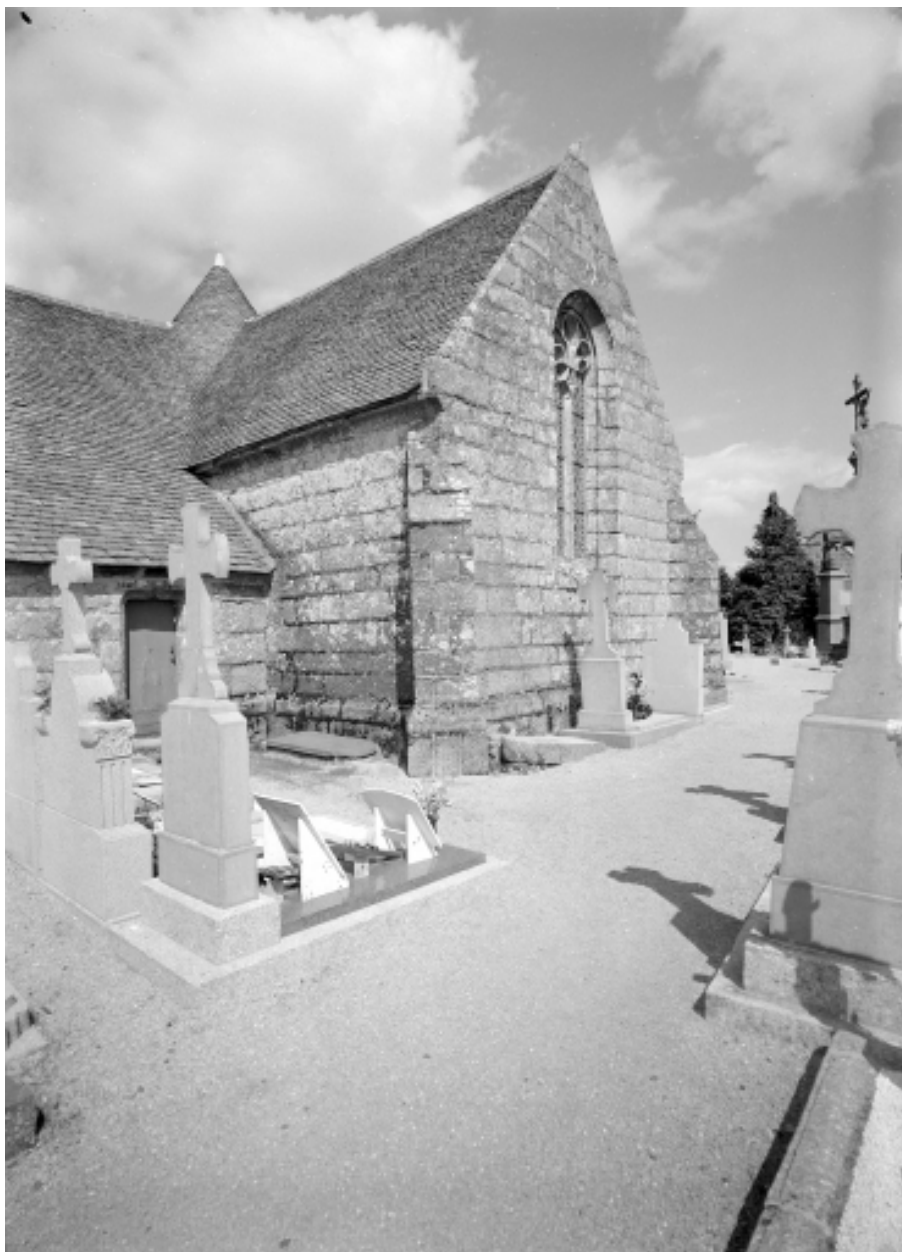
Bras sud du transept, vue prise du sud-ouest
