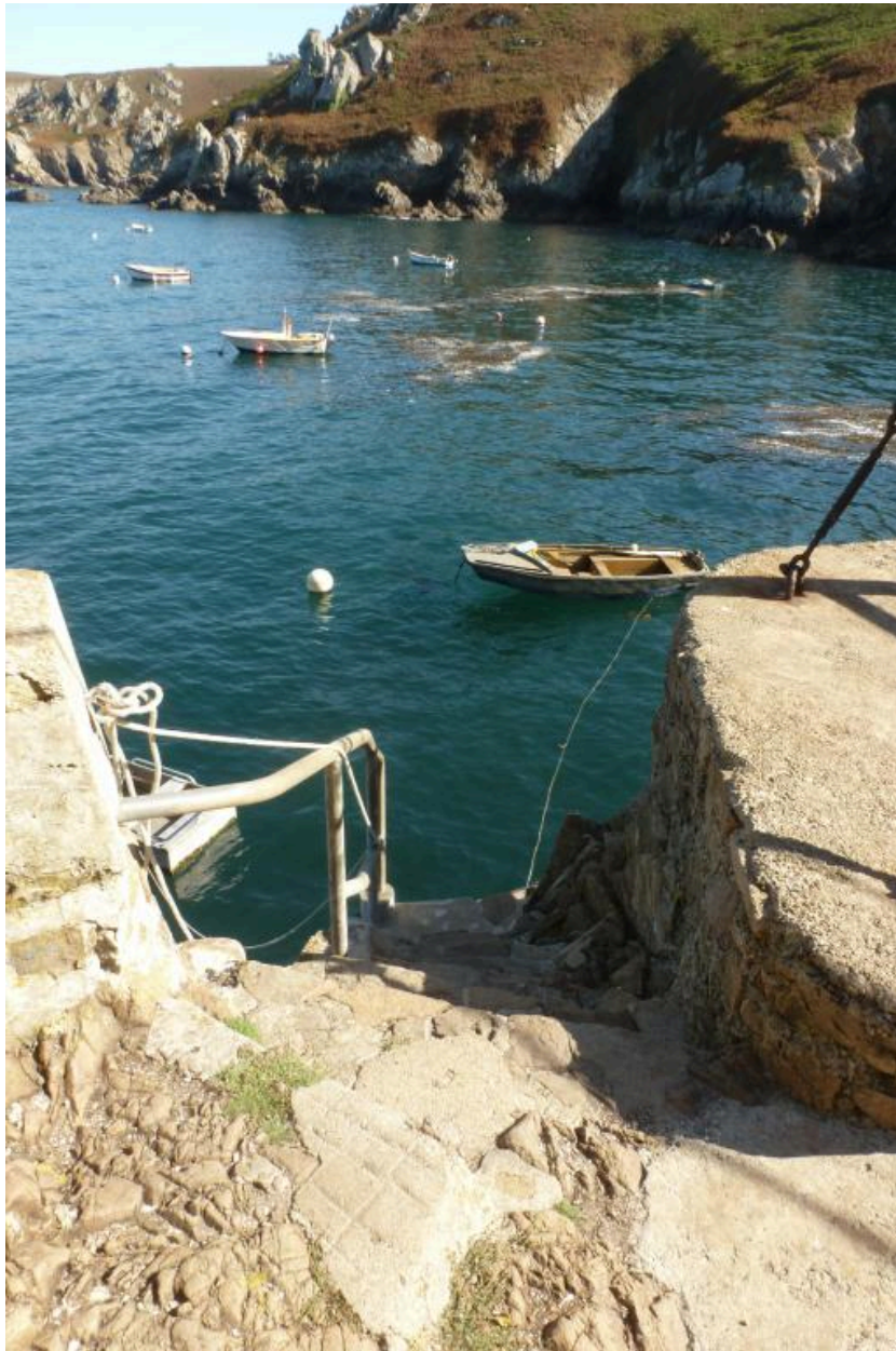
Débarcadère pour les pêcheurs, détail de l'escalier.
