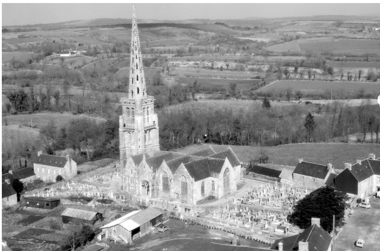
Vue aérienne prise du sud-est
