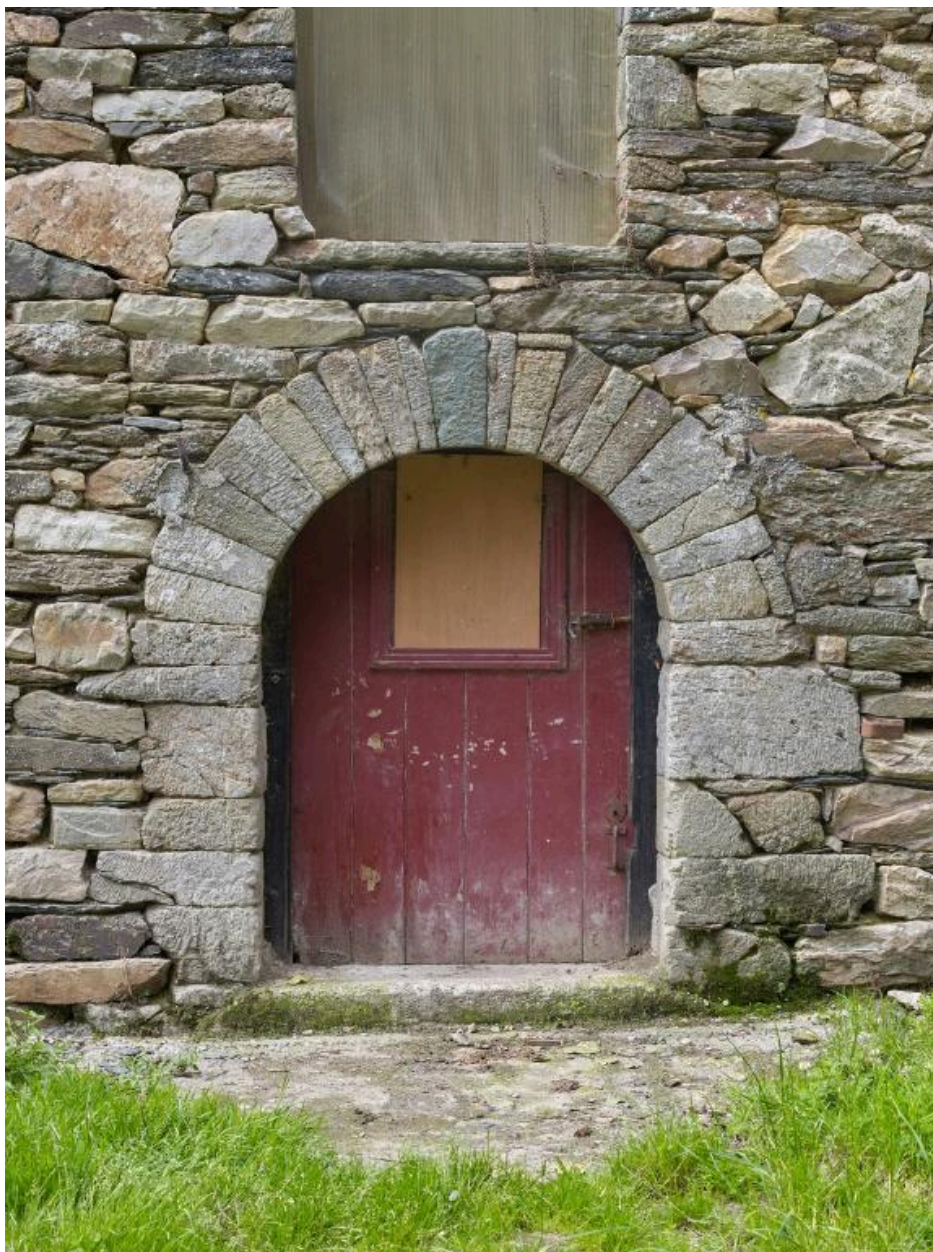
Logis-étable. Façade sud-est. Porte cintrée à claveaux de schiste très soignés
