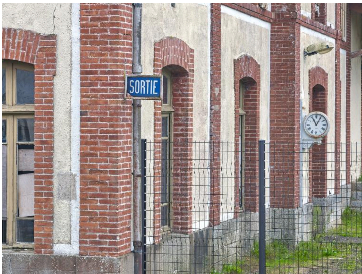
Gare de Brélidy-Plouëc, enduit, encadrement en brique, chaînage d'angle en brique
