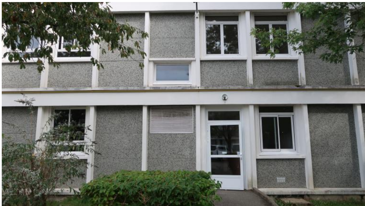
Internat, façade ouest : détail. Yves Guillou, architecte, 1969.
