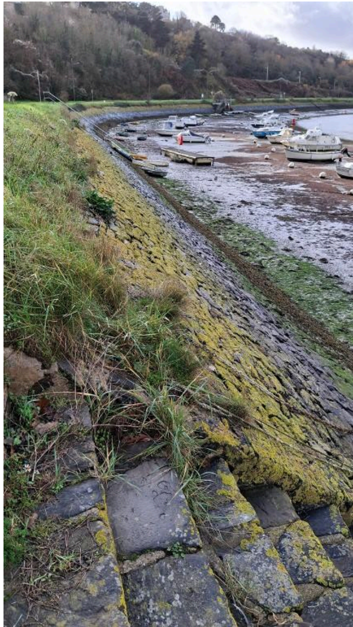
Perrés de la rive droite, avant-port
