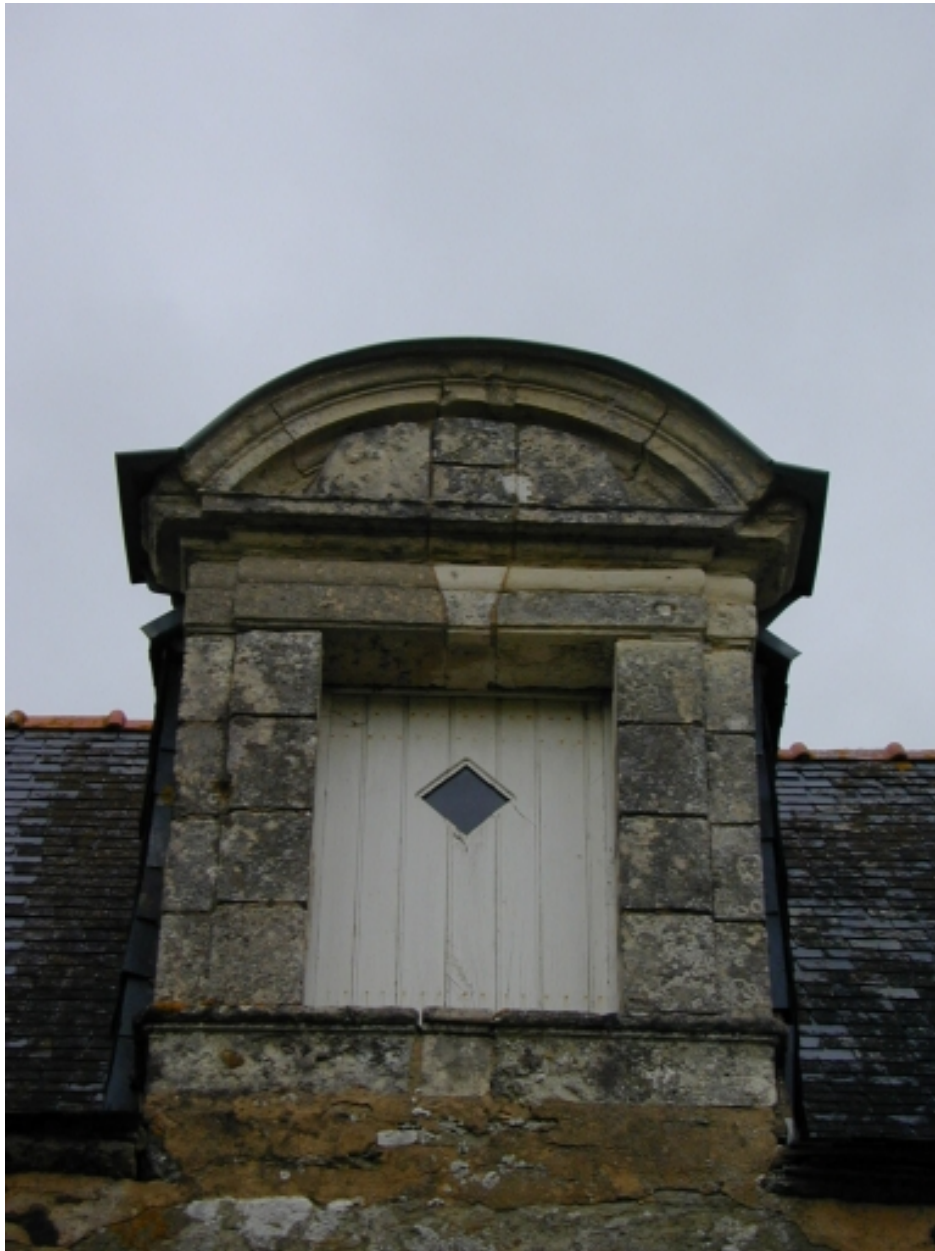
Communs, façade antérieure, lucarne en tuffeau : vue générale
