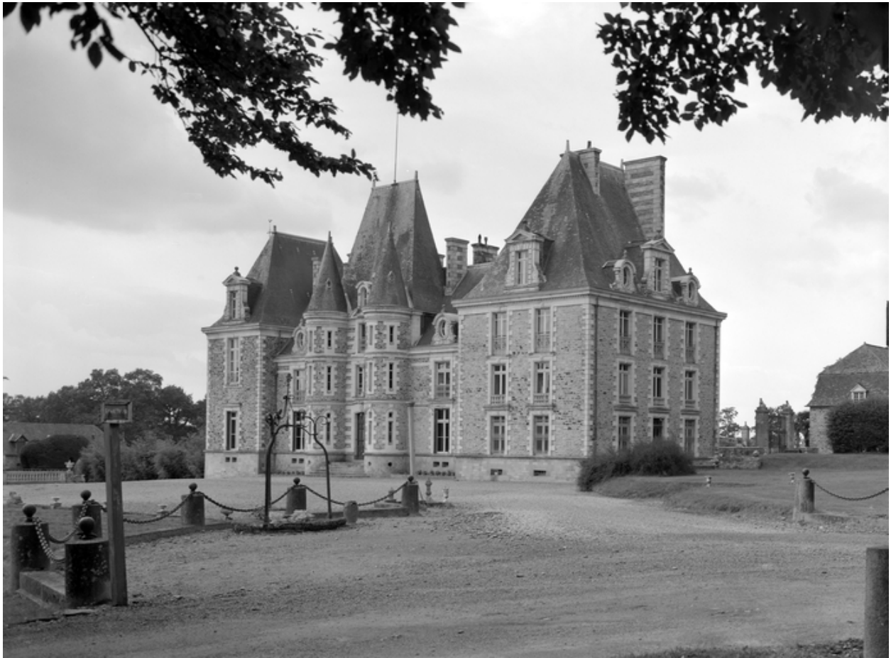
Elévation est, vue générale.
