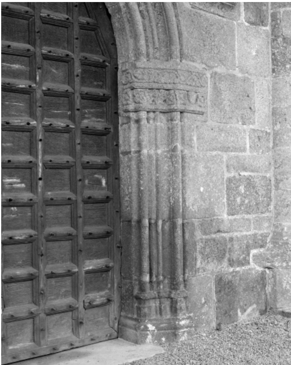
Porte ouest, ébrasement de droite.
