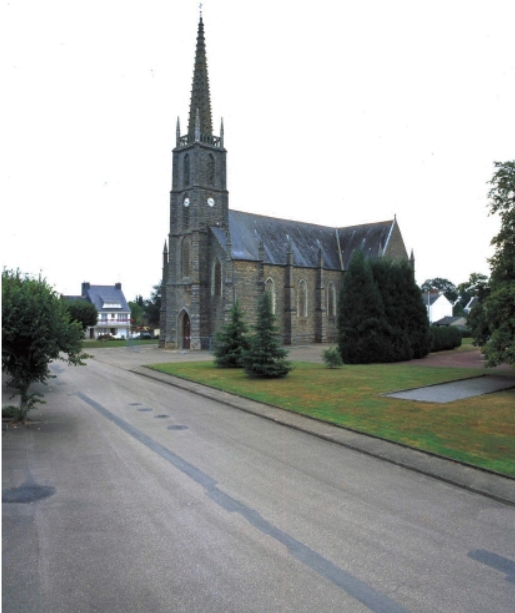
Vue générale : élévation sud-ouest
