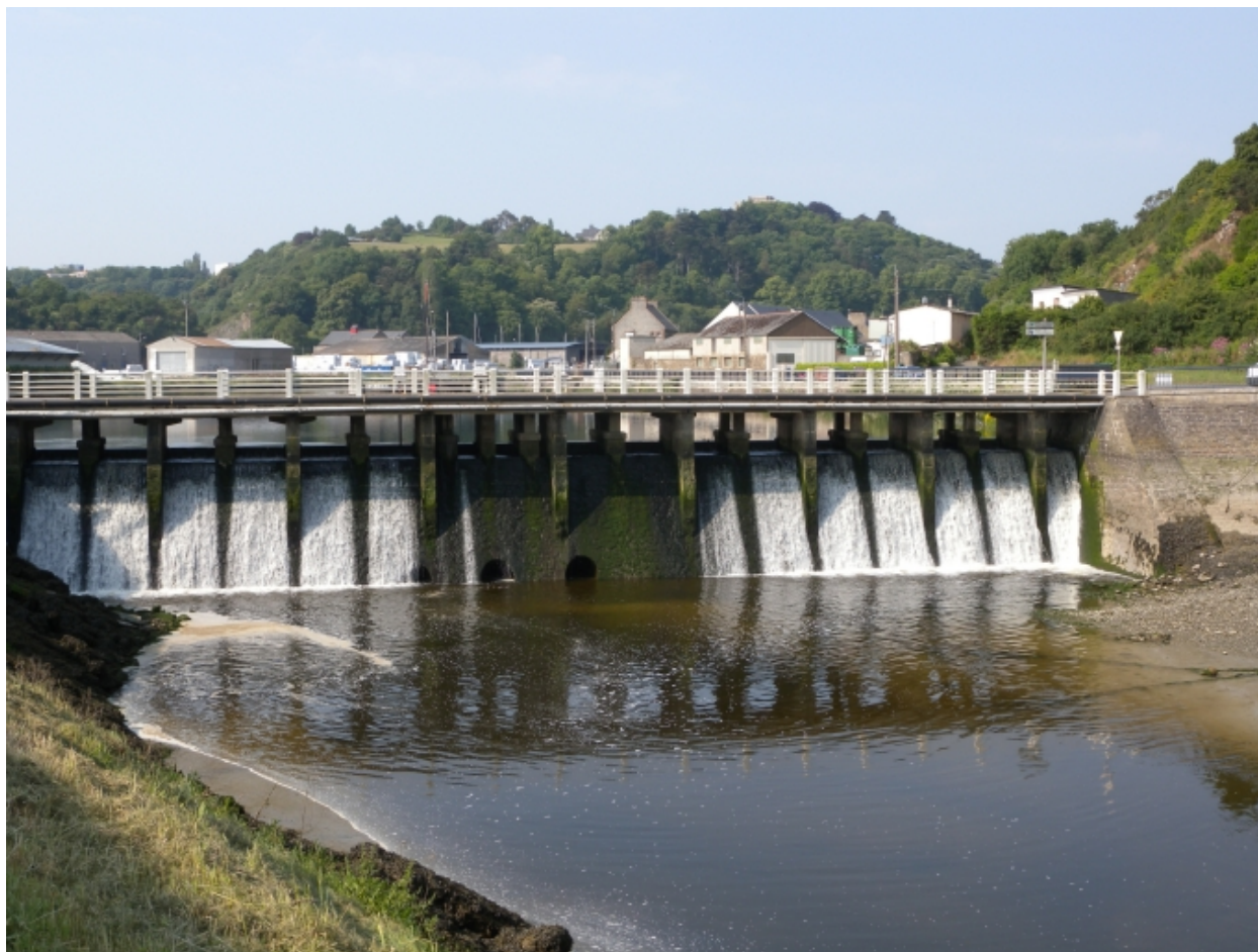
Vue du pont déversoir
