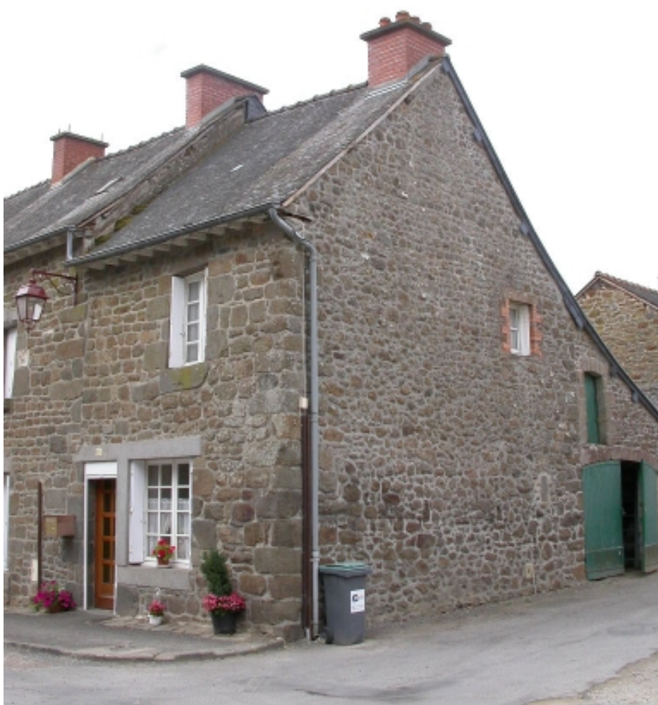
Vue générale nord-est
