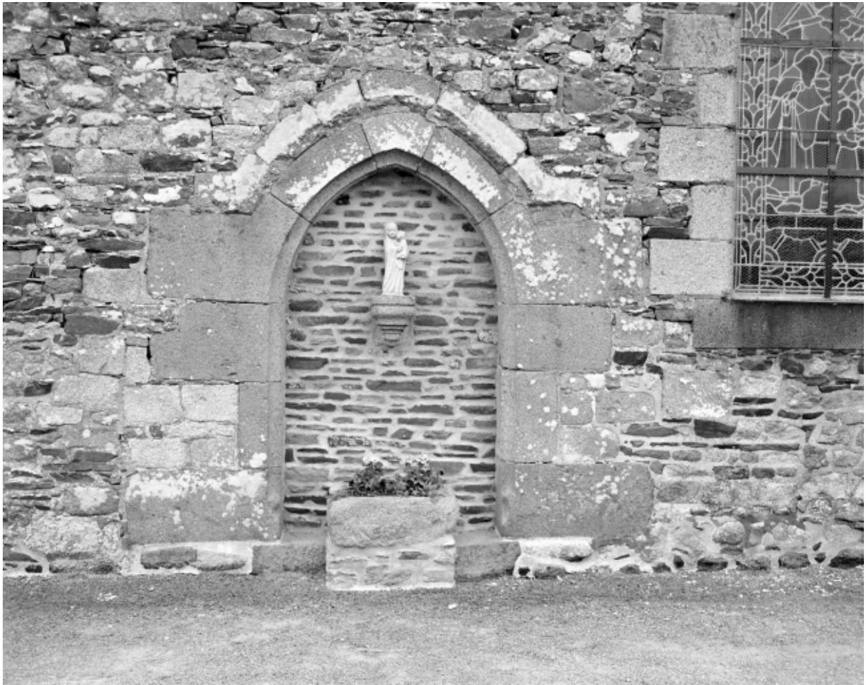
Elévation Sud, porte : vue générale
