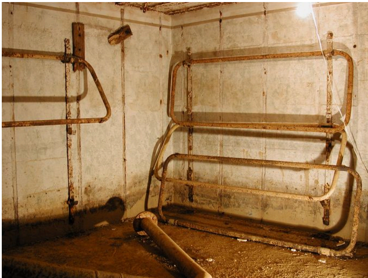
Vue de la chambre de troupe gauche : lits - couchettes superposées (modèle 923S4 tubulaire et rabattable)
