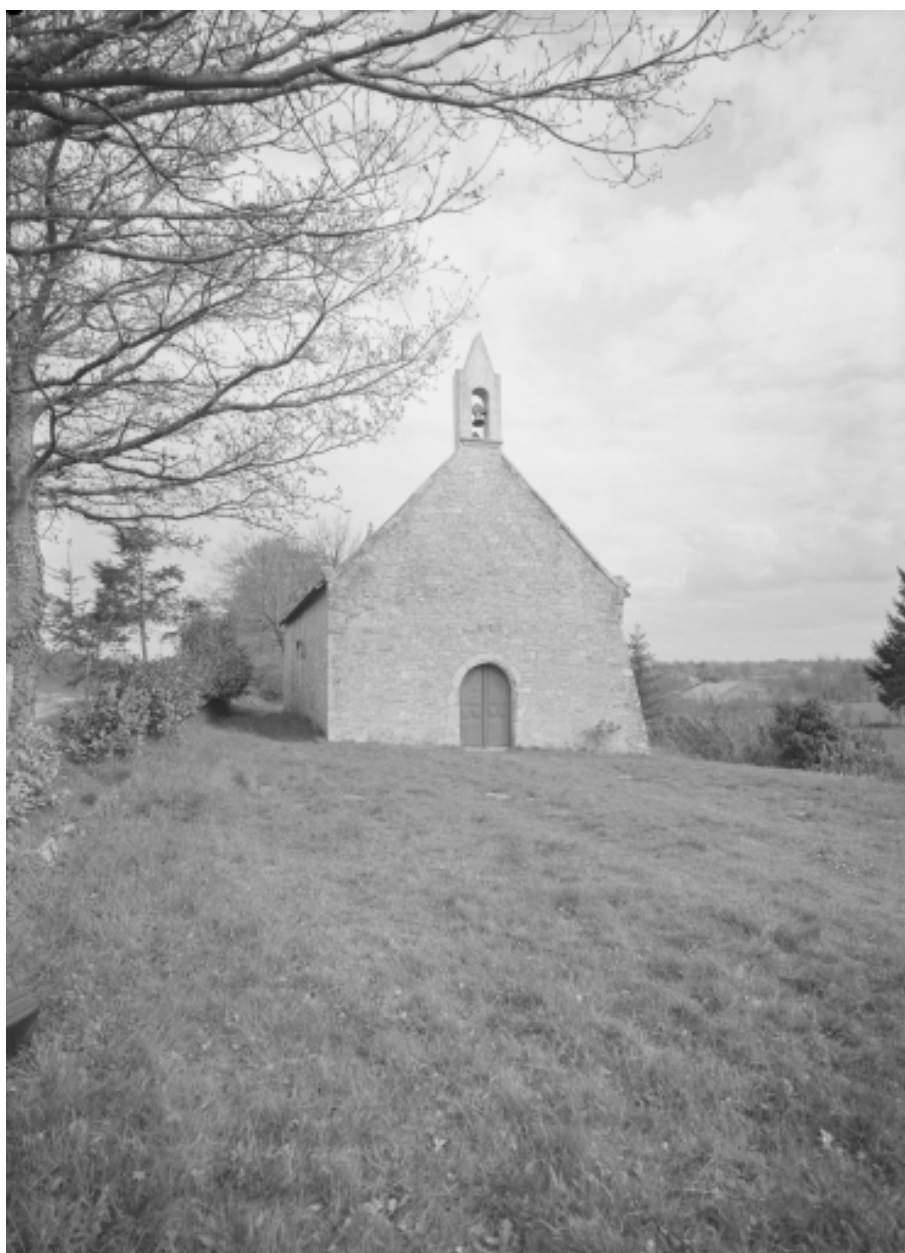
Elévation Ouest : vue générale
