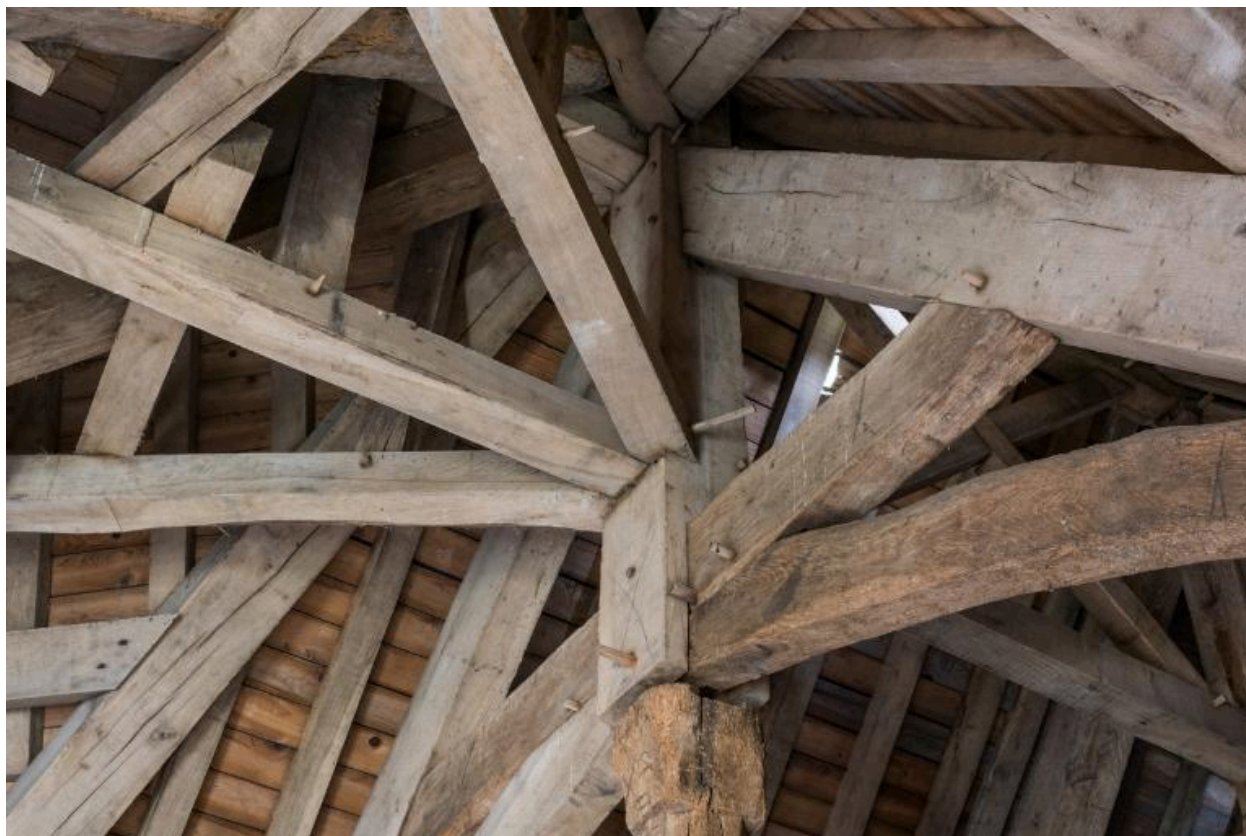
Vue de la charpente de l'abside à trois pans du chœur.
