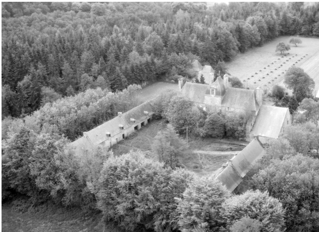
Vue aérienne prise du nord, état en 1969
