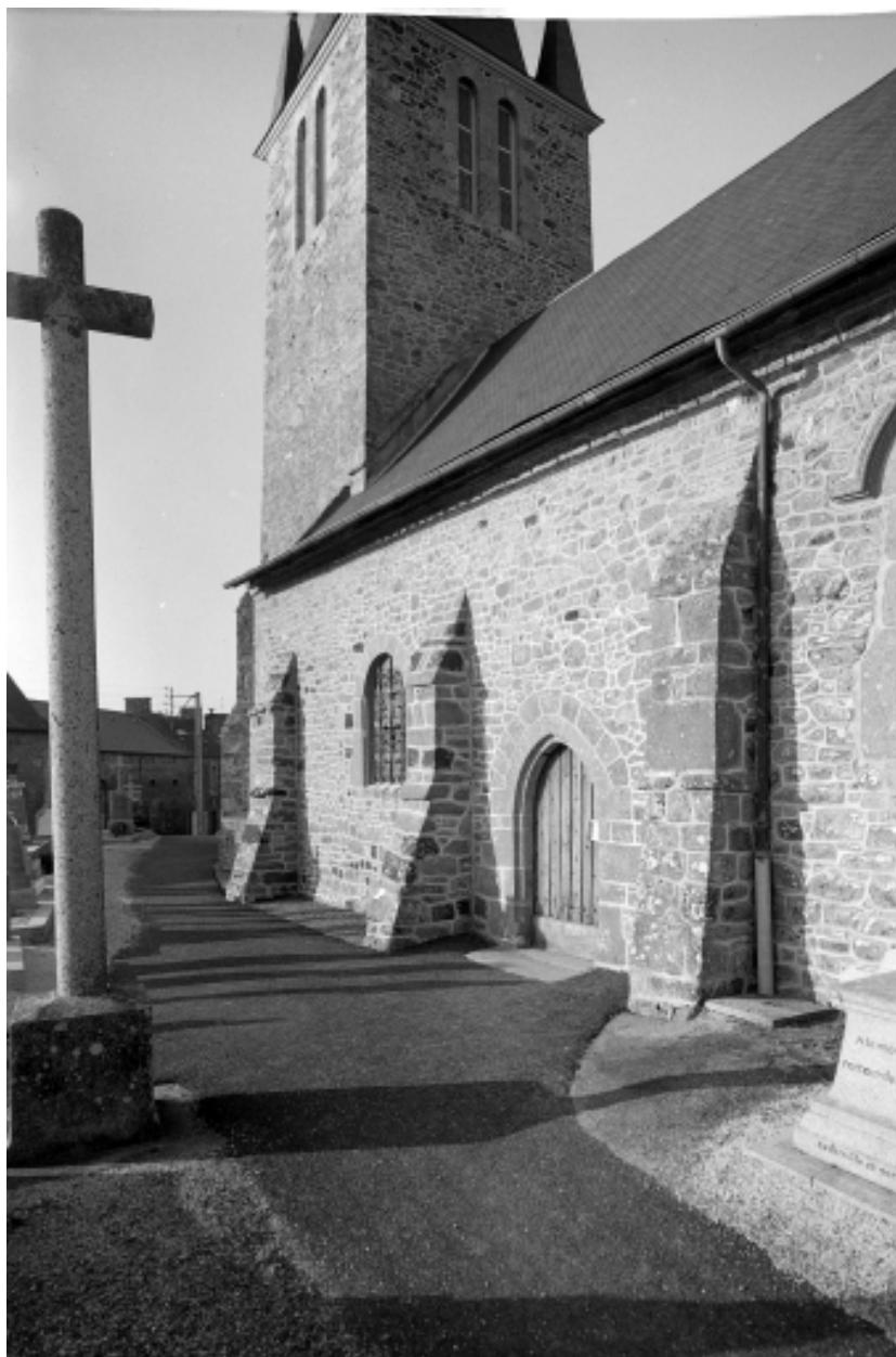
Façade sud : partie ouest.
