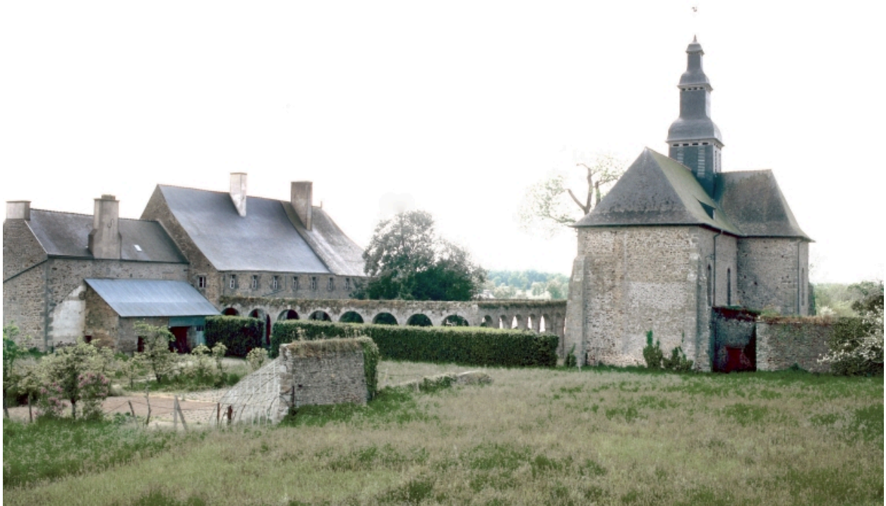
Elévation Est : vue générale
