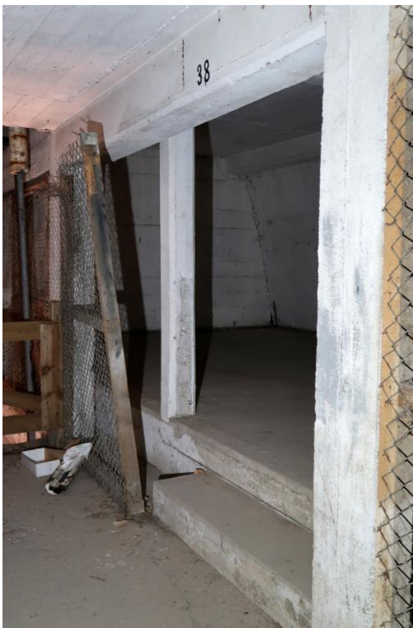
Premier étage : extrémité sud, box 38
