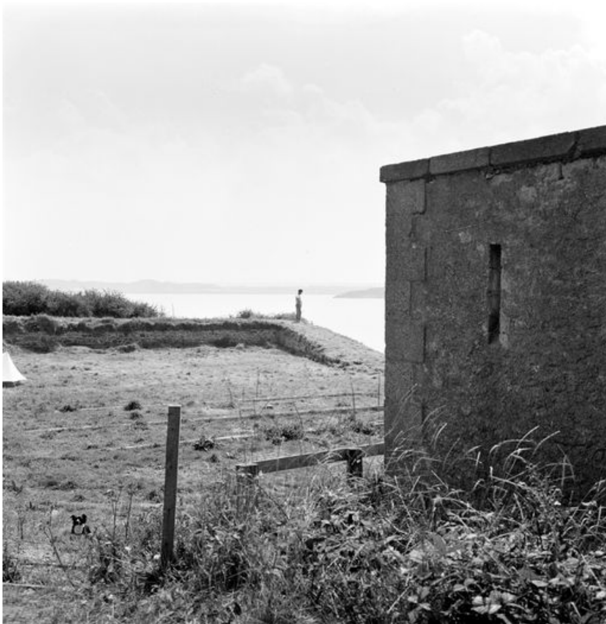
Vue du corps de garde crénelé n° 3 et de la batterie du bourg de Roscanvel en 1969
