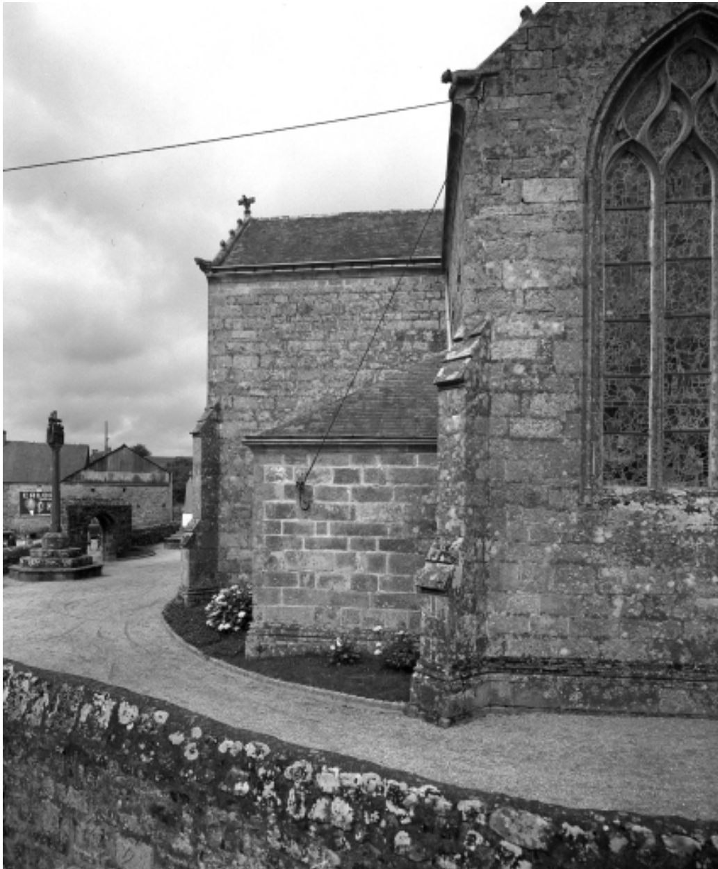
Quéménéven, église paroissiale Saint-Ouen : façade sud, partie est, état en 1972
