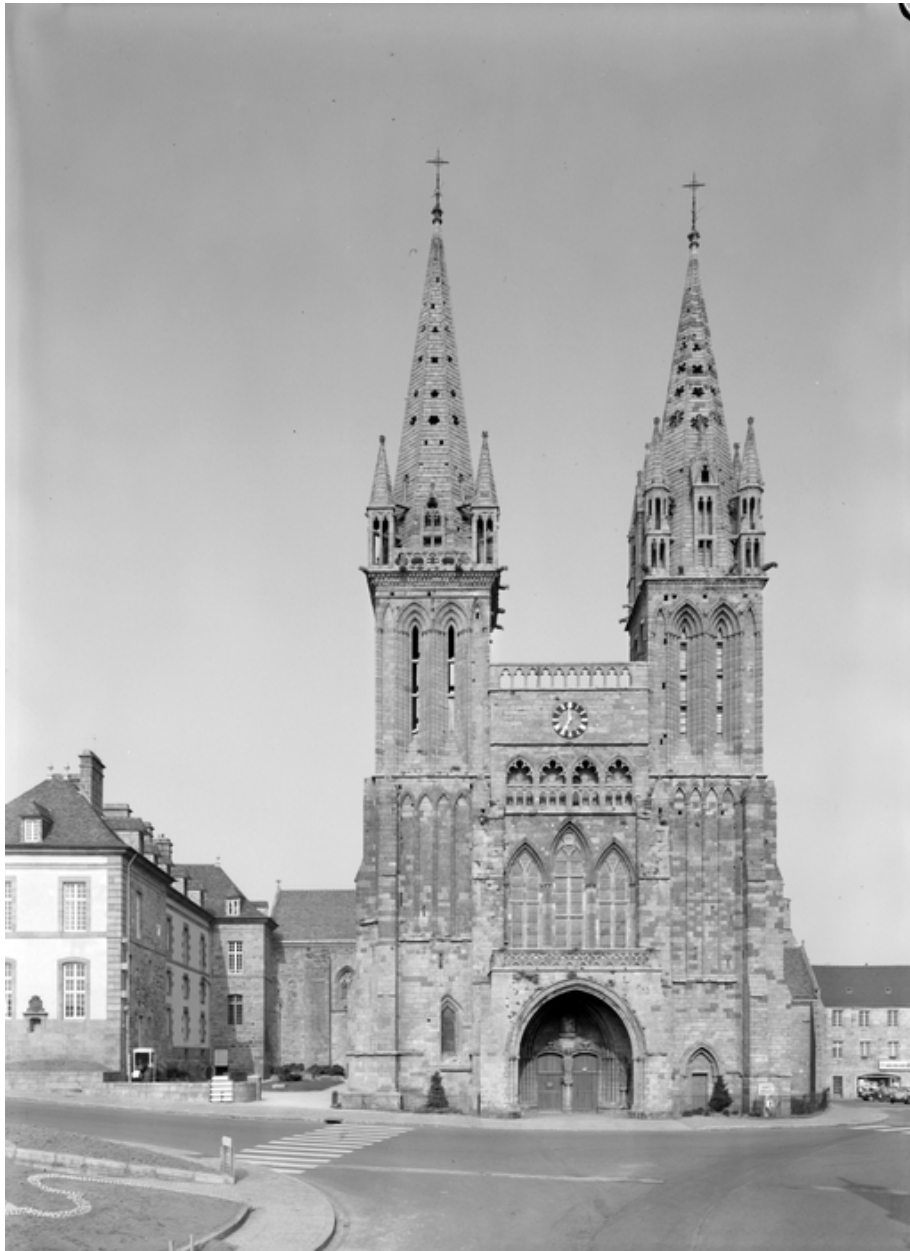
Elévation ouest, vue générale
