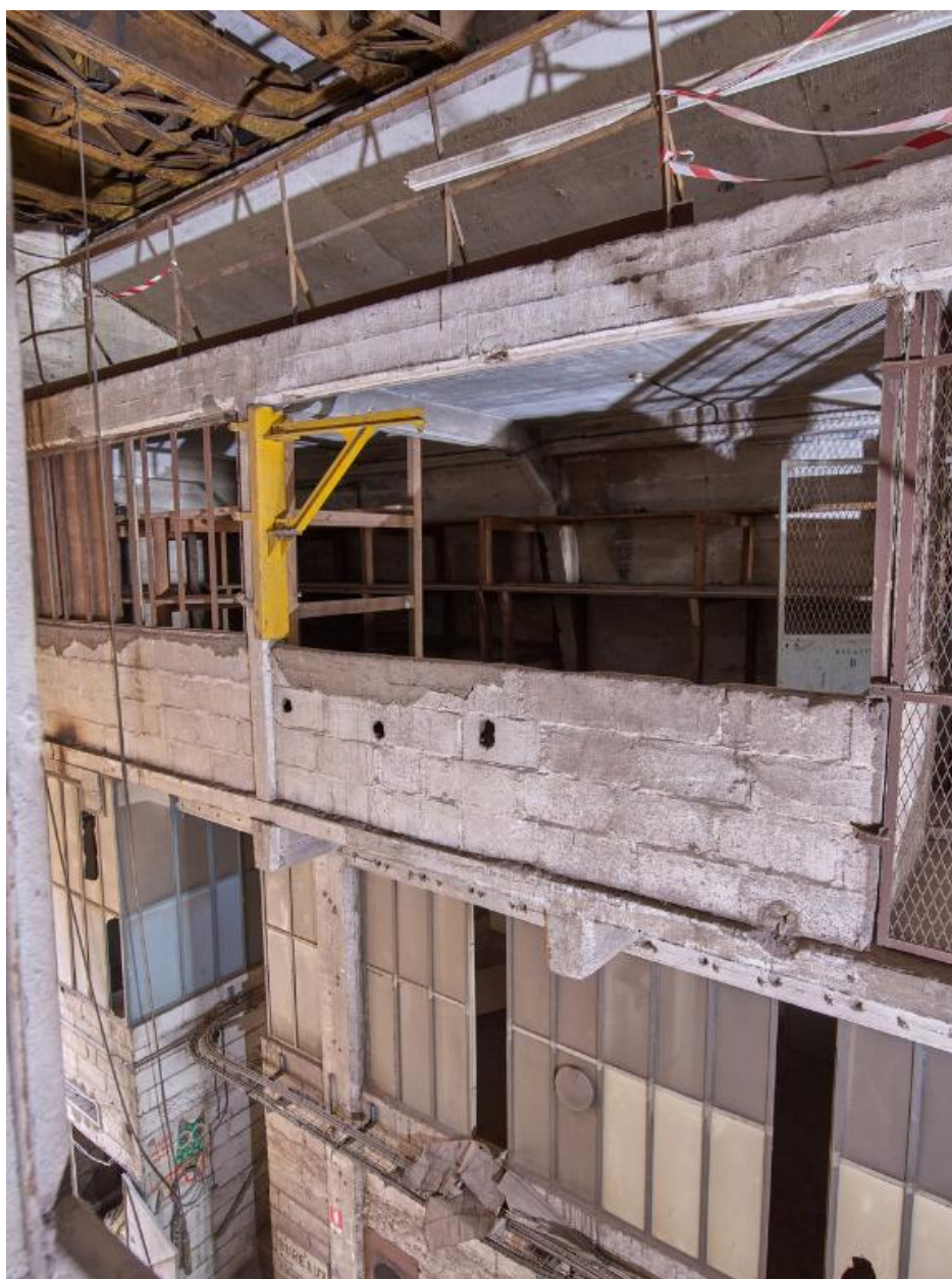
Vue des ateliers et bureaux ouest de la nef : niveaux supérieurs
