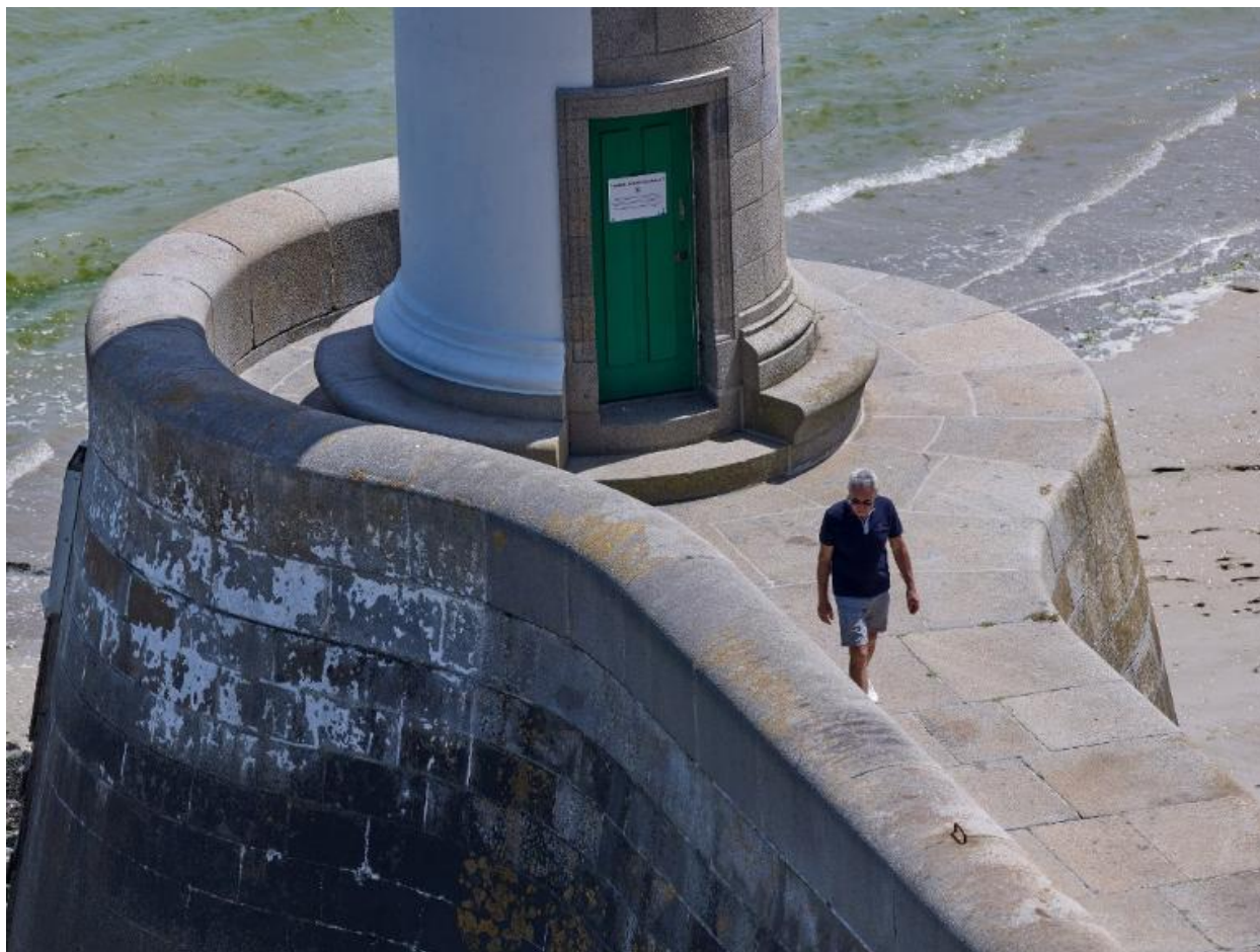
Le phare et la jetée : vue de la mise en oeuvre des maçonneries
