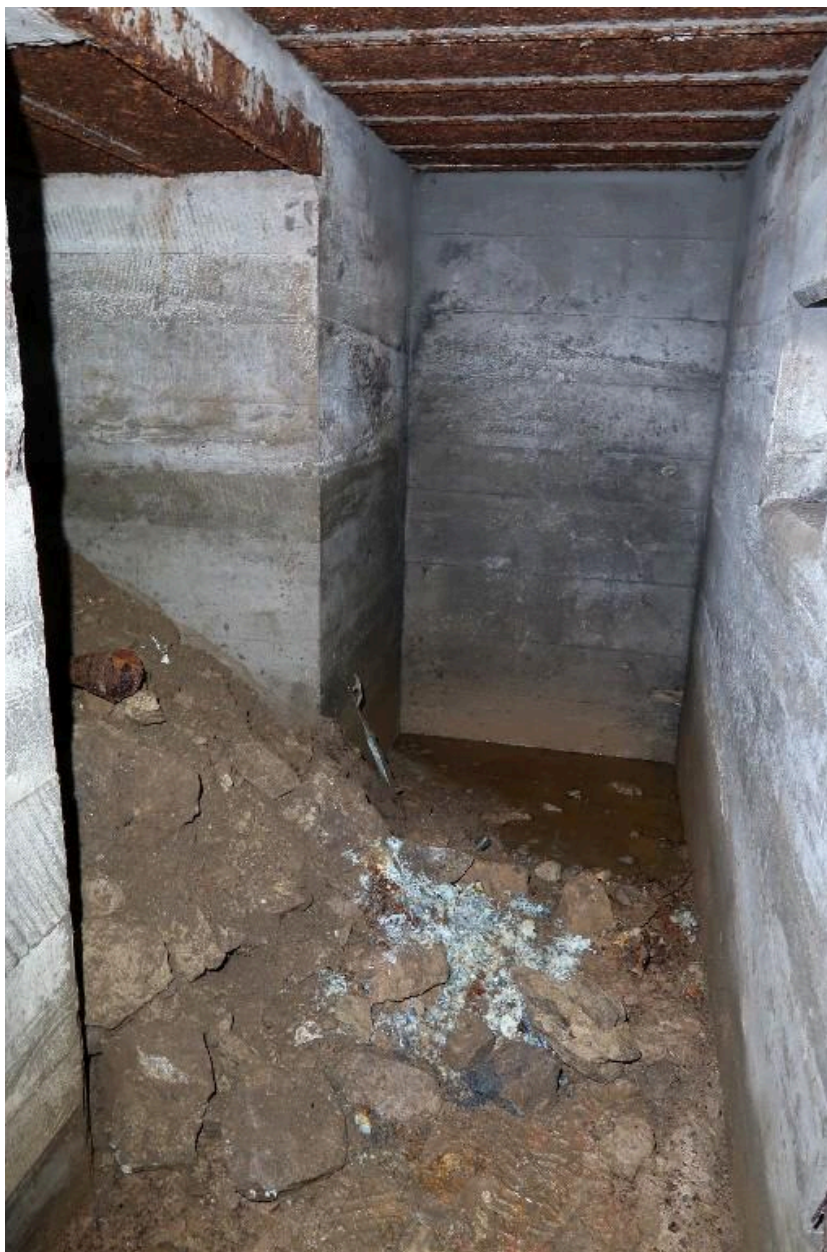
Vue de l'entrée sud et de l'extrémité du couloir sud
