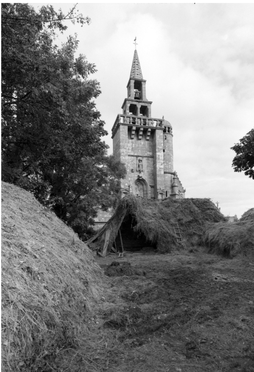
Vue générale de la façade ouest
