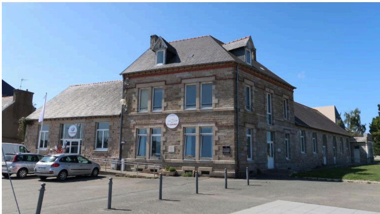
Vue d'ensemble, angle nord-est.
