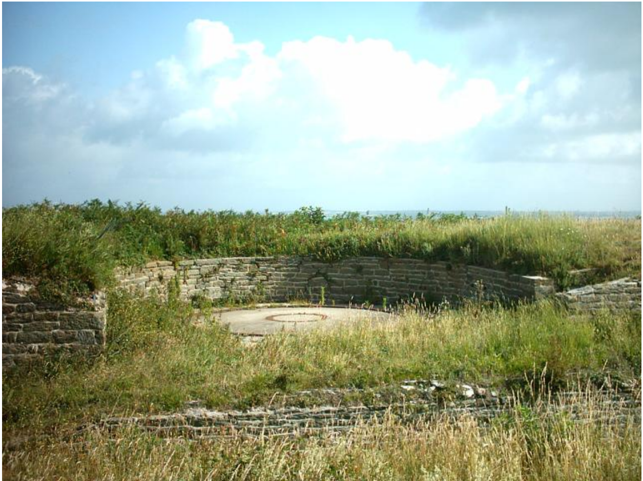
Groix, batterie du Bas-Grognon, plate-forme de canon de 24 cm en 2007.
