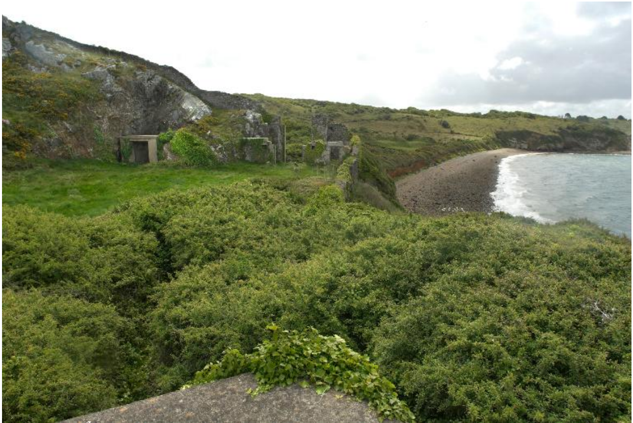
Vue du terre-plein de la batterie basse : porte d'entrée du fort avec tambour et corps de garde ; à gauche, abri de jour du poste photo-électrique (état en 2009)
