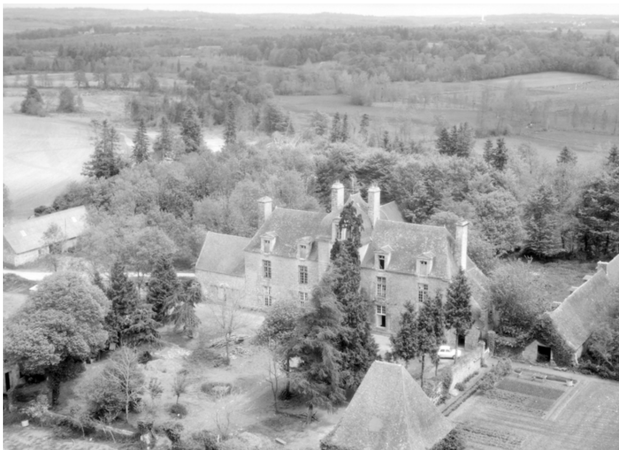
Vue aérienne prise du sud-est, état en 1969
