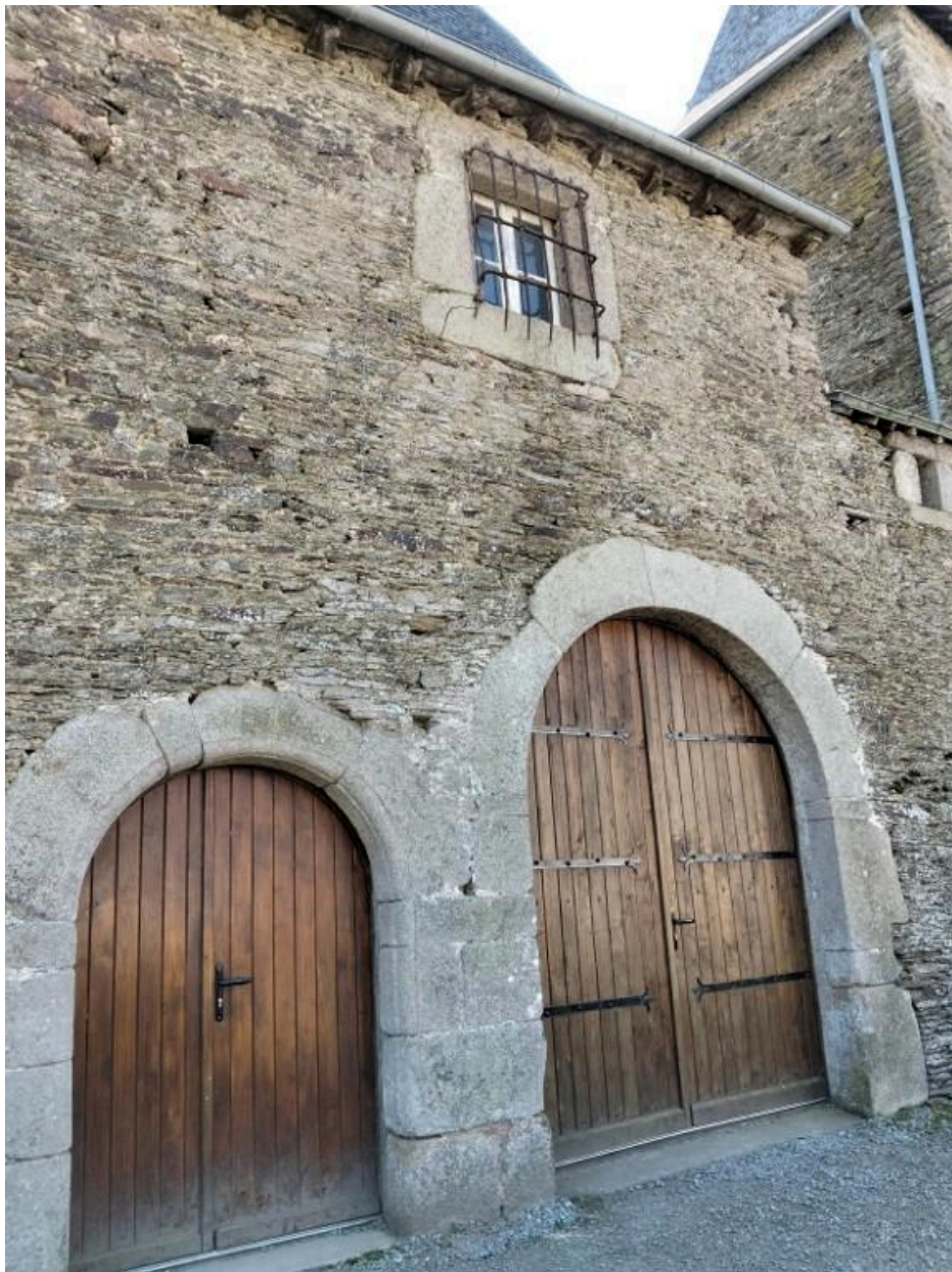
Portes, façade nord
