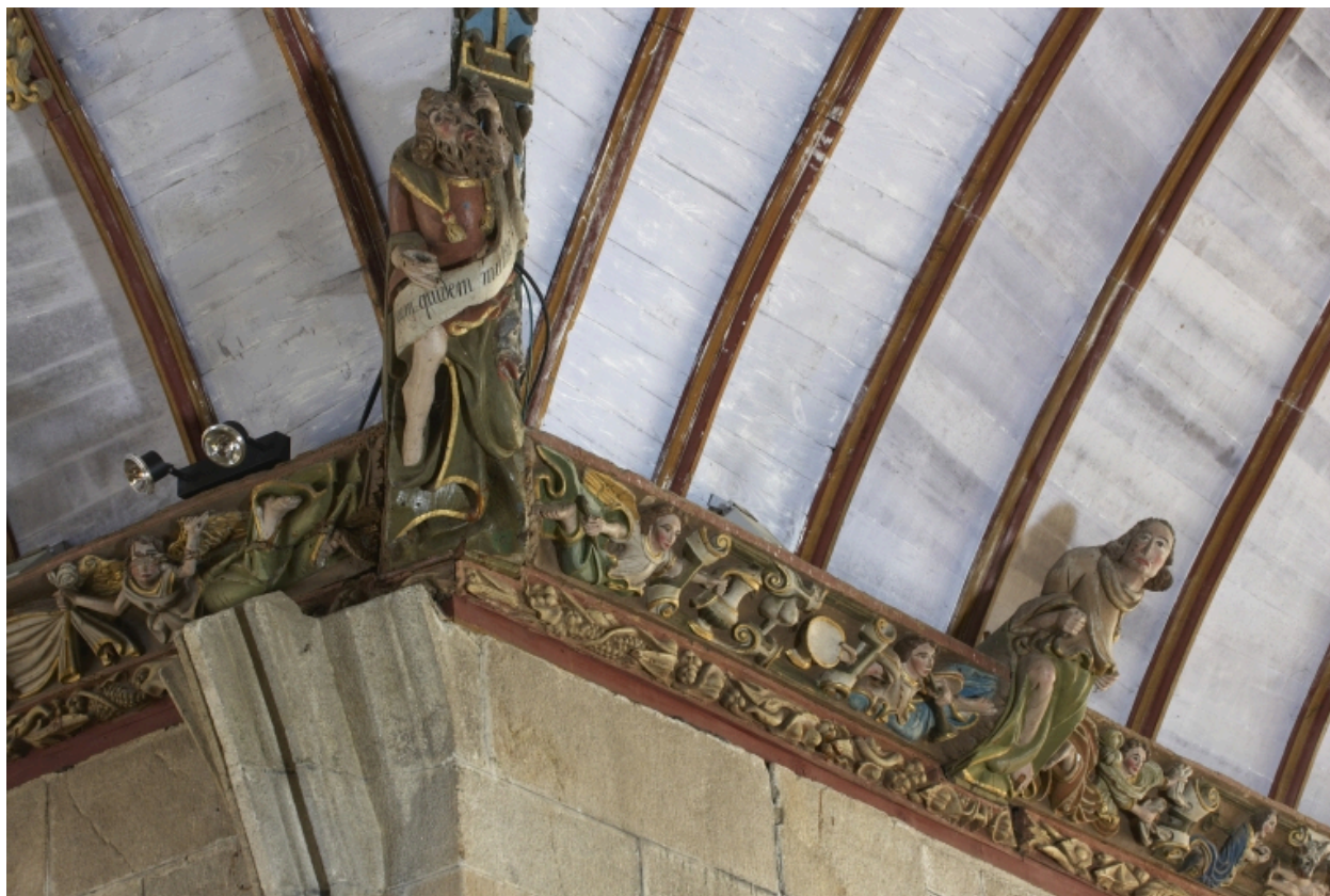
Intérieur, mur est du bras sud, détail de la sablière et du blochet
